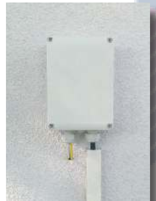
Asennettu ulkopäätekotelo
