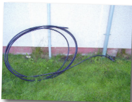
Kuitu voidaan tuoda rakennuksen seinälle myös putkessa
