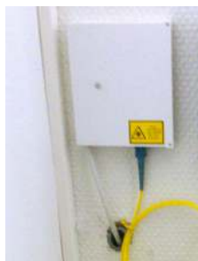
Häntäkaapelin läpivienti ja asennettu sisäpäätekotelo
