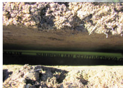
Varoitusnauha varoittaa alla olevasta kaapelista
